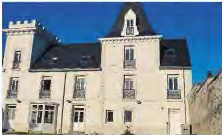
Des travaux de remise en conformité ont été entrepris depuis 2016 par l'association PEP Brétil'Armor dans ce manoir du XIX e siècle.
