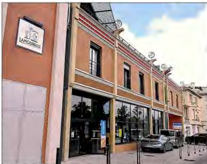
Le centre de séjour international accueille 35 chambres.
