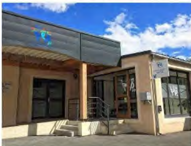
Le nouveau bâtiment des Pep 36, rue Combanaire, à Châteauroux.
