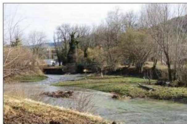
Les travaux sur le Lange sont terminés. Photo Progrès/Roger GUILLOT
