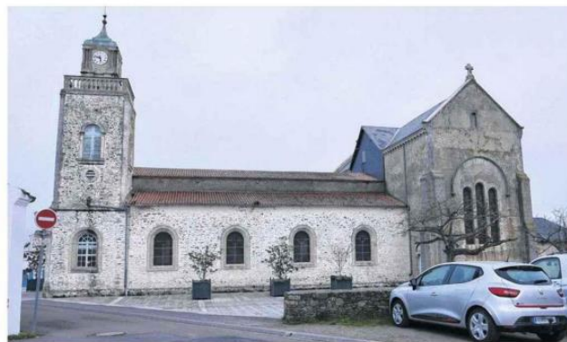
L'église du port nécessite 1 million € de travaux de réfection
