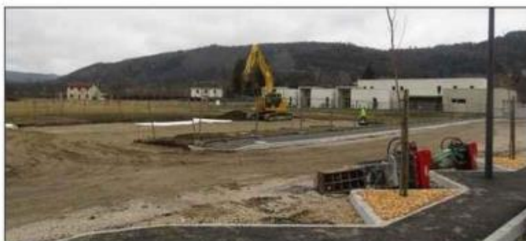
Le projet PEP 01 comprend la construction en cours de l'accueil de jour et au fond de l'IME avec les services liés.
