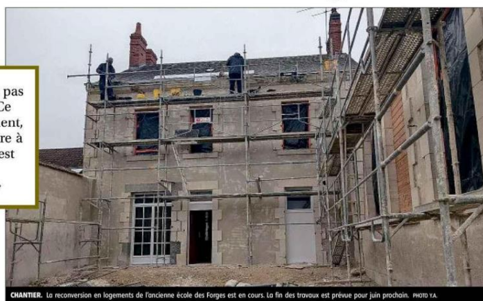
CHANTIER. La reconversion en logements de l'ancienne école des Forges est en cours. La fin des travaux est prévue pour juin prochain. PHOTO YA.
