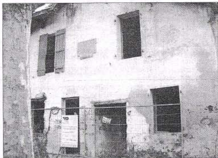
Seul le pignon de la ferme Dongoxenia sera conservé pour accueillir la maison d'accueil des jeunes enfants. PHOTO E.A.
